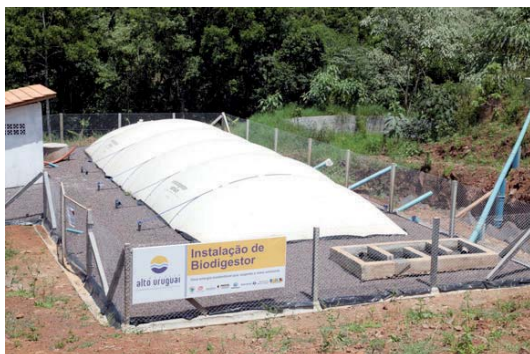
Figura 25 - Foto do biodigestor de Chapecó (Santa Catarina), instalado pelo projeto “Alto Uruguai”, com capacidade para produzir 27.623 KW de energia por ano. (Fonte: Projeto Alto Uruguai, www.projetoaltouruguai.com.br/index.fp )
