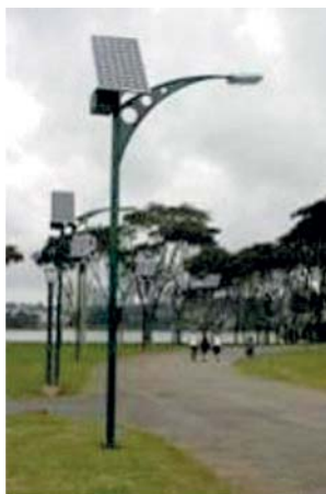
Figura 20: Iluminação com painéis solares no Parque Barigui de Curitiba (Fonte: http://painelsolares.com/energia-solar-no-brasil )
